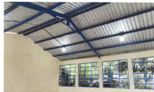
Foto 6. Instalación de la estructura de metal y techado del aula del modulo 1.
