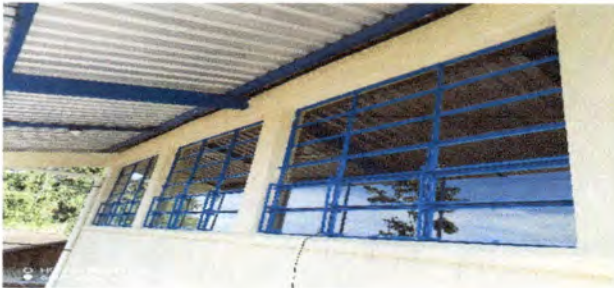
FOTO 3. Instalación de los ventanales del aula módulo 1.
