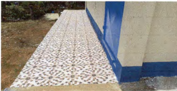
foto 5. Colocación de piso antideslizante en el pasillo del aula del modulo 1.
