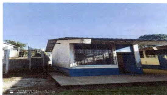
Foto 10. Instalación de lámina troquelada Aluzinc calibre 26 en la dirección del módulo 2.
