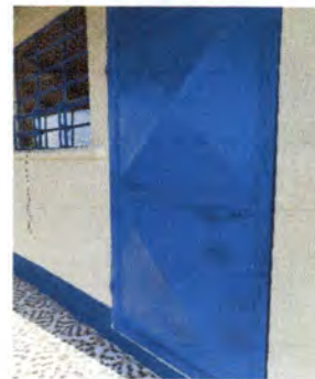
Foto 4. Instalación de la puerta de metal del aula nueva del módulo 1.
