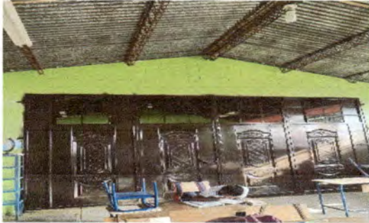
foto 1. Instalación del portón de metal para la división de aulas.
