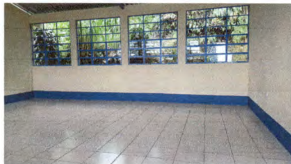
Foto 8. colocación del piso cerámico en aula nueva del módulo 1.
