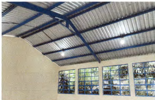
Foto 7. Instalación del cableado eléctrico en el aula del módulo 1.
