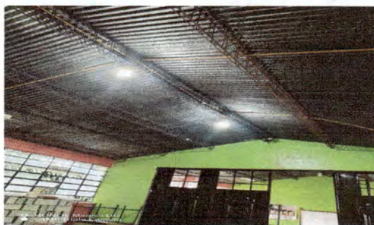
Foto 11. Instalación de lámparas , interruptores y tomacorrientes en el módulo 2.
