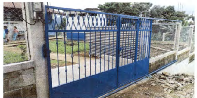
Foto 2. Instalación del portón de metal de entrada principal.
